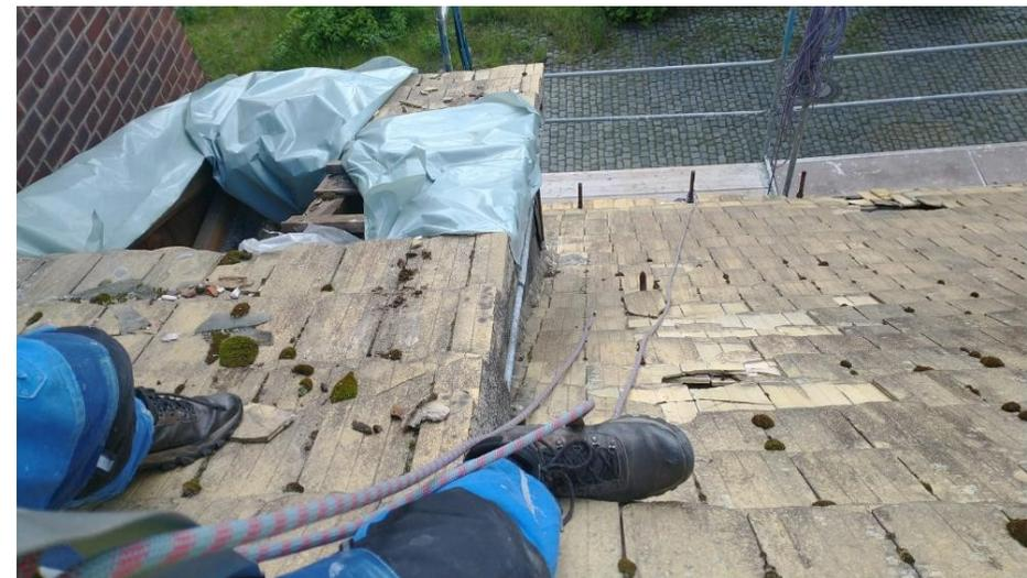
Abbildung 6: Dachnotsicherung über Mitropa-Küche in Eigenleistung (Foto T. Reinsch, 28.5.2021)
